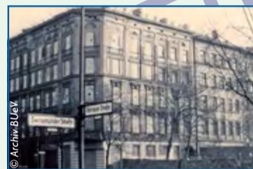
Vermauertes Haus an der Bernauer Straße (1962).
