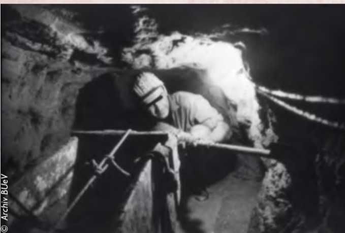
»Tunnel 57« im Bau, September 1964.
